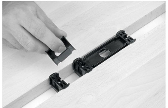
*Modalità d'uso dello strumento di posizionamento nell'incasso*
